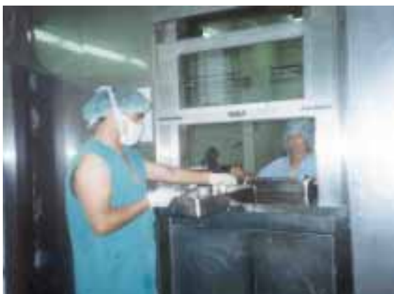
(Fig. No. 6) La ventana de paso, es un elemento importante entre la zona roja (contaminada) y la zona azul (limpia), pues permite el acceso de los materiales que han sido descontaminados y que deberán ser preparados, empaçados y esterilizados.
